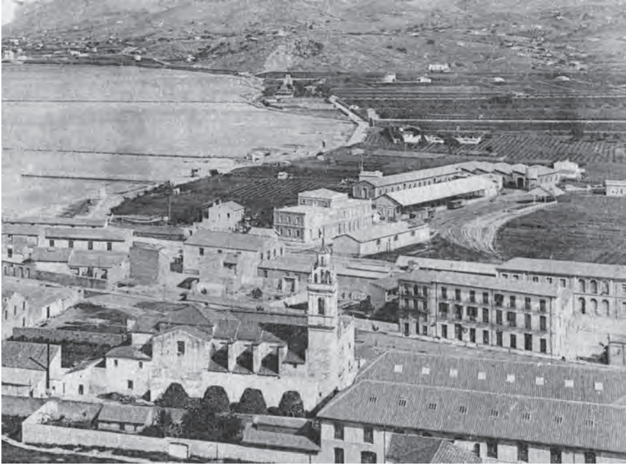
Vista general de les instal·lacions ferroviàries a Dénia. Al fons a l'esquerre els edificis dels tallers, anys 1915-1918. Font: Arxiu Antoni Reig
