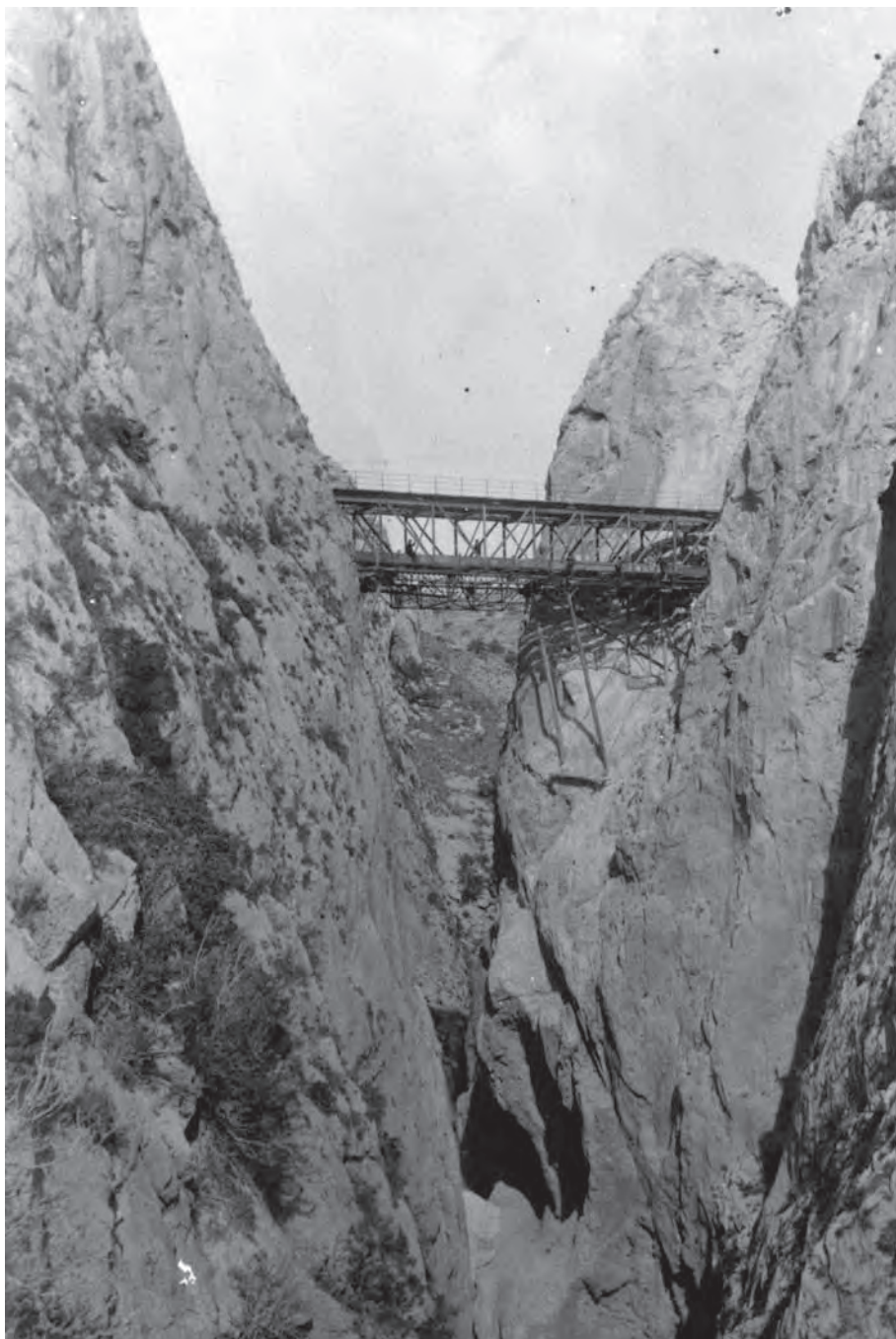
Imatge de la construcció del pont del Mascarat, encara amb les mènsules utilitzades per la construcció. Foto Col·lecció Vicente Ferrer.
