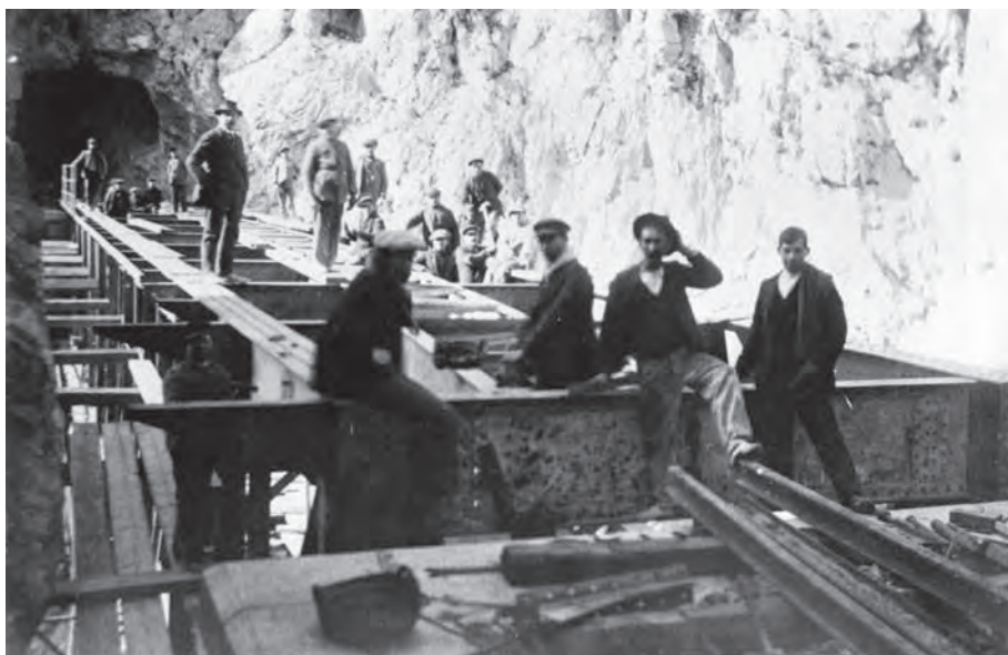
Construcció del pont del Macarath amb una longitud de 42 metres i una altura de 85 metres amb un radi de corba per a la via de 150 m. Destaca la manca de mesures de seguretat per als treballadors. Foto Cervera, Benissa, Col·lecció Vicente Ferrer.
