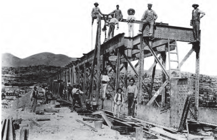
Construcció del pont de Santa Anna o del Quisi amb la presència de mà d'obra infantil. Foto FFE Archivo B. Gramaje.
