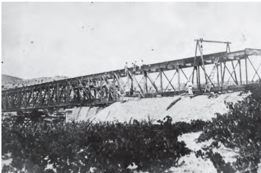
El pont o viaducte de Santa Anna o del Quisi en construcció. Foto Col·lecció Vicente Ferrer.
