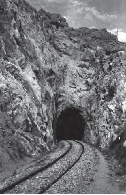
Boca d'un dels nombrosos túnels del ferrocarril, excavat en la roca directament sense cap revestiment. Foto Col·lecció Vicente Ferrer.
