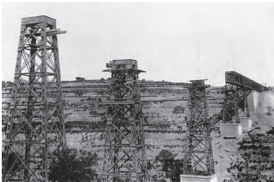
El pont o viaducte de Santa Anna o del Quisi, una de les obres ferroviàries més esveltes dels ferrocarrils de via mètrica. Imatges de la construcció. Foto FFE Archivo B. Gramaje.
