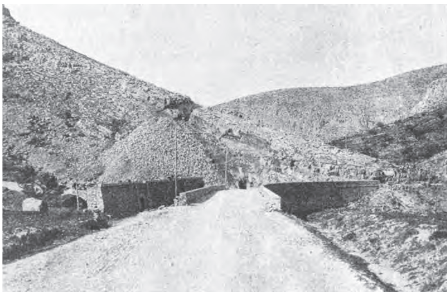
Obres d'avanç de l'explanació del ferrocarril en el paratge conegut com la Garganta. En primer plànol la C.M. 332 . Foto Col·lecció Vicente Ferrer.
