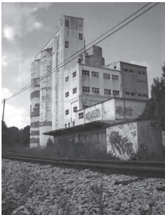
Les instal·lacions de CEMESA hui. En primer plànol la via fèrria, a continuació la caseta de la bàscula, al fons les sitges de magatzematge del ciment en situació de degradació total, i a continuació la zona de càrrega dels vagons. Foto Vicente Ferrer.
